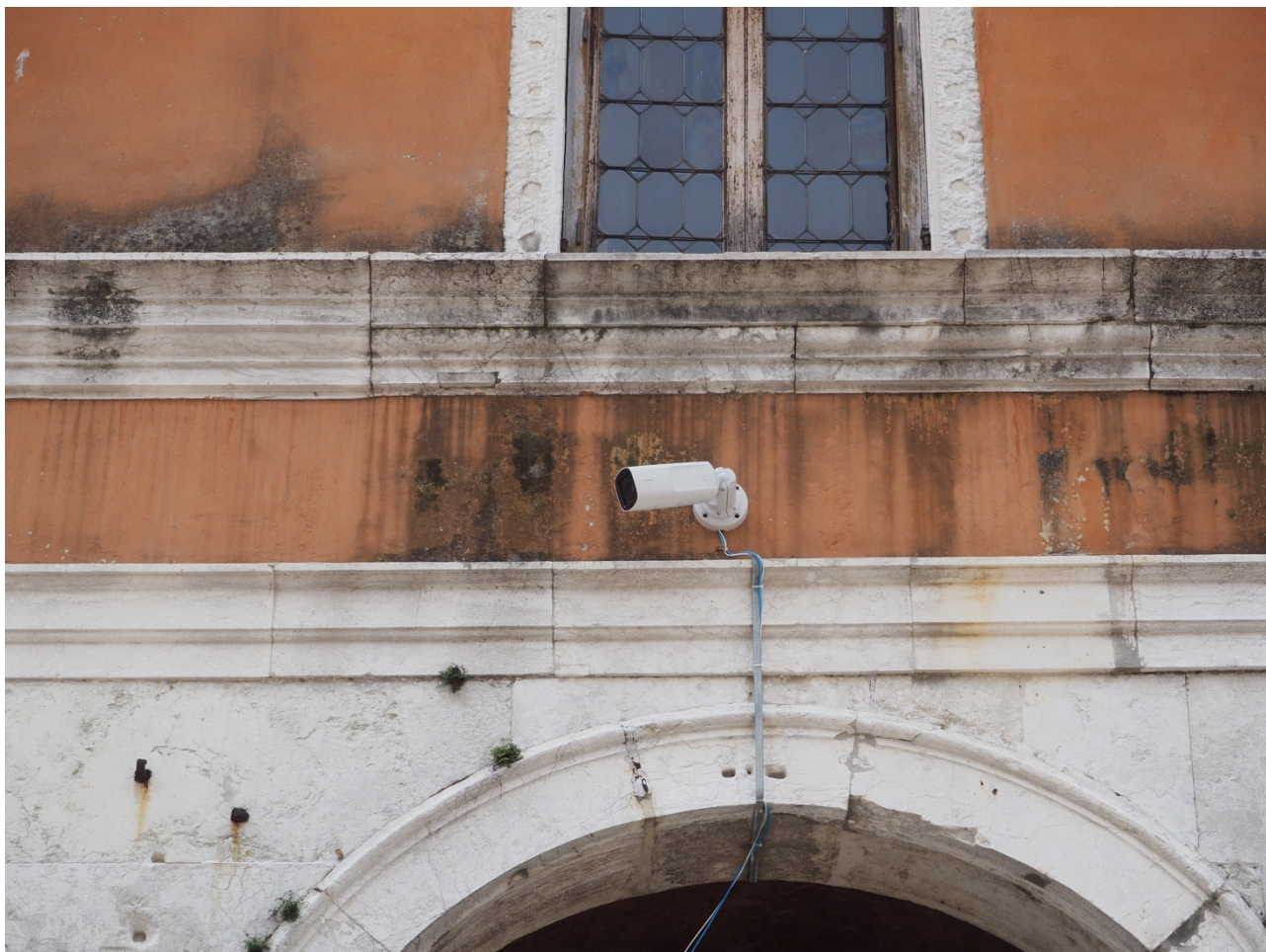
Figura 14 - Telecamera - Ruga Oresi (vista laterale)
