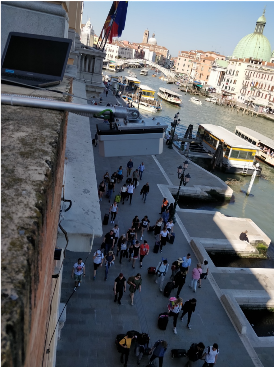
Figura 3 - Barriera laser – Regione Veneto - fondamenta della stazione
